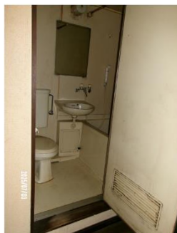
〈改修前〉3点ユニット （段差あり）
